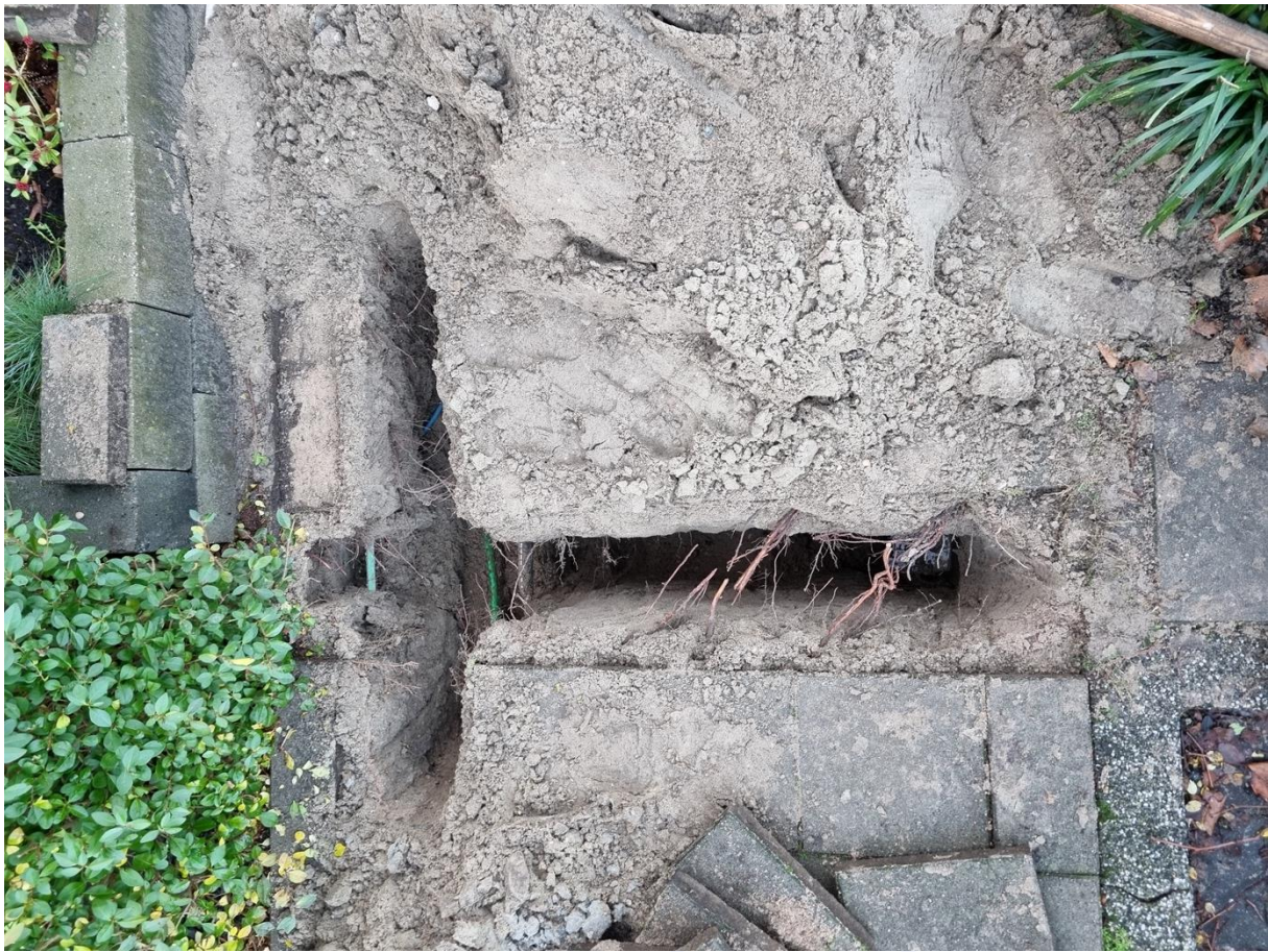
Foto 13 : proefsleuf boomnummer 3, trottoir
