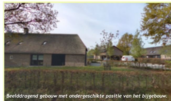
Bedrijfsbebouwing: sobere en doelmatige vormgeving en uitstraling.
