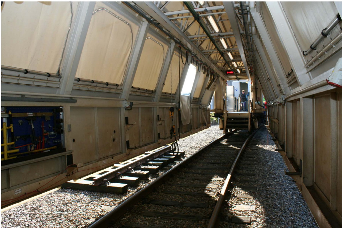
▲ Figuur 69: Binnenzijde van een mobiele werkplaats, waarbij de baanwerkers binnen deze beveiligde omgeving veilig kunnen werken. (bron: OVnieuws.info)
