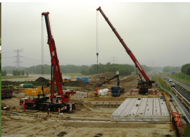
Uitvoering kruising Doorbraak met rijksweg A35 (lekkage kleiwanden)
