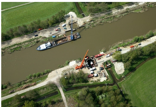
Uitvoering kruising Doorbraak zijtak Twentekanaal (zwerfkeien problematiek)
