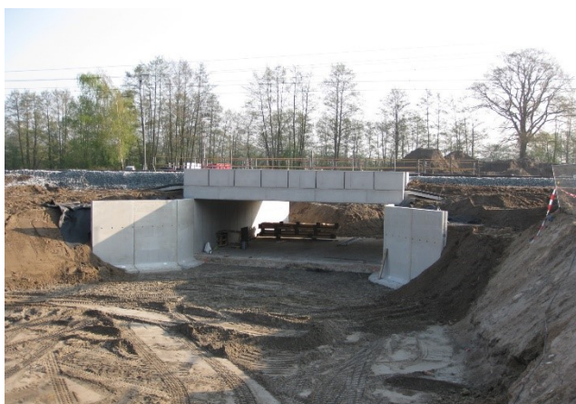
Uitvoering kruising Doorbraak met spoorlijn Almelo-Hengelo (gunning- en financiële problemen)
