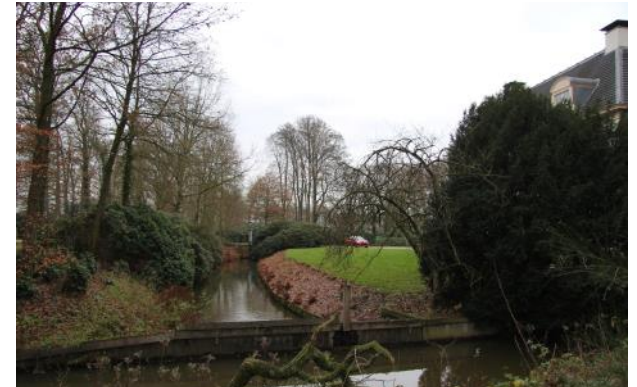
Houten stuw aan de zuidzijde van het terrein
