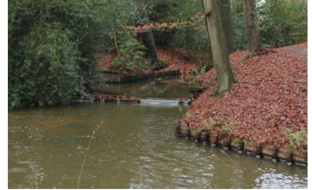
Houten dam aan de noordzijde van het terrein
