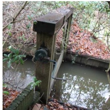
Houten sluis aan de noordzijde van het terrein
