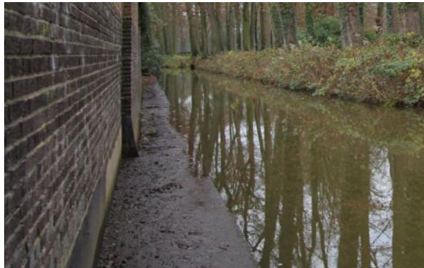
Betonnen rand langs de tuinmuur
