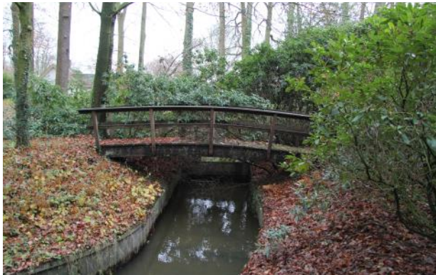
Afgesloten houten brug tussen het huiseiland en het eiland
