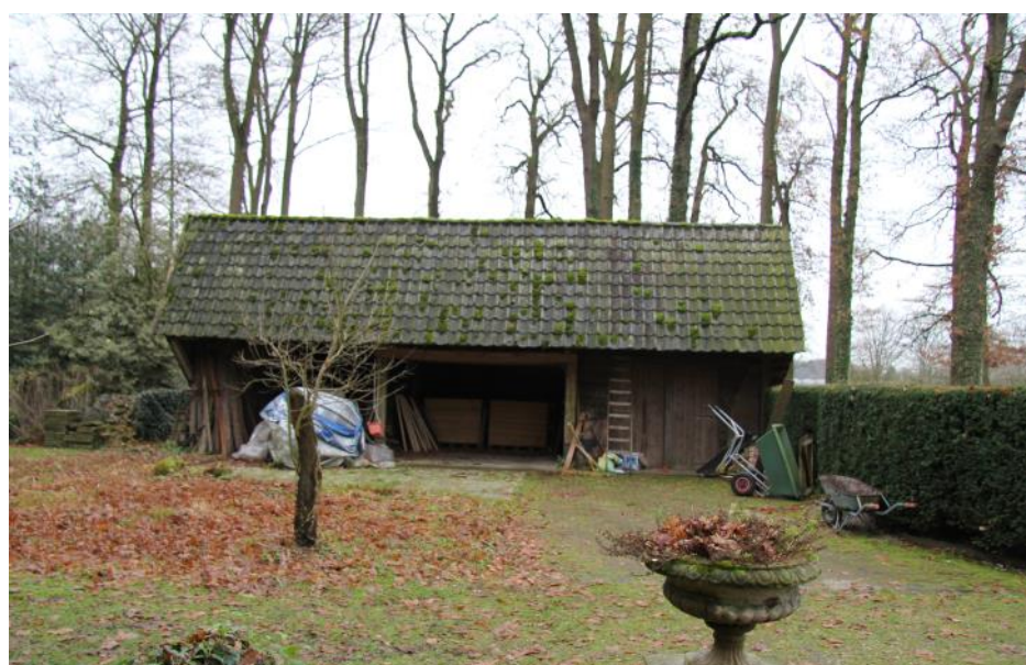
Voor de schuur ligt aan de rechterzijde een plein van klinker met keien, en aan de linkerzijde van grindtegels
