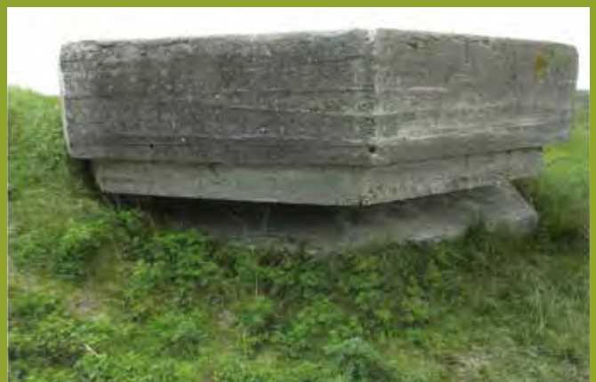
Bunkerelement D 19 van de Vleermuisbunker, foto 2013.
