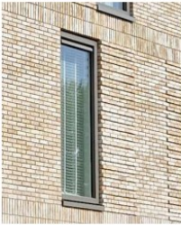
A. licht metselwerk
