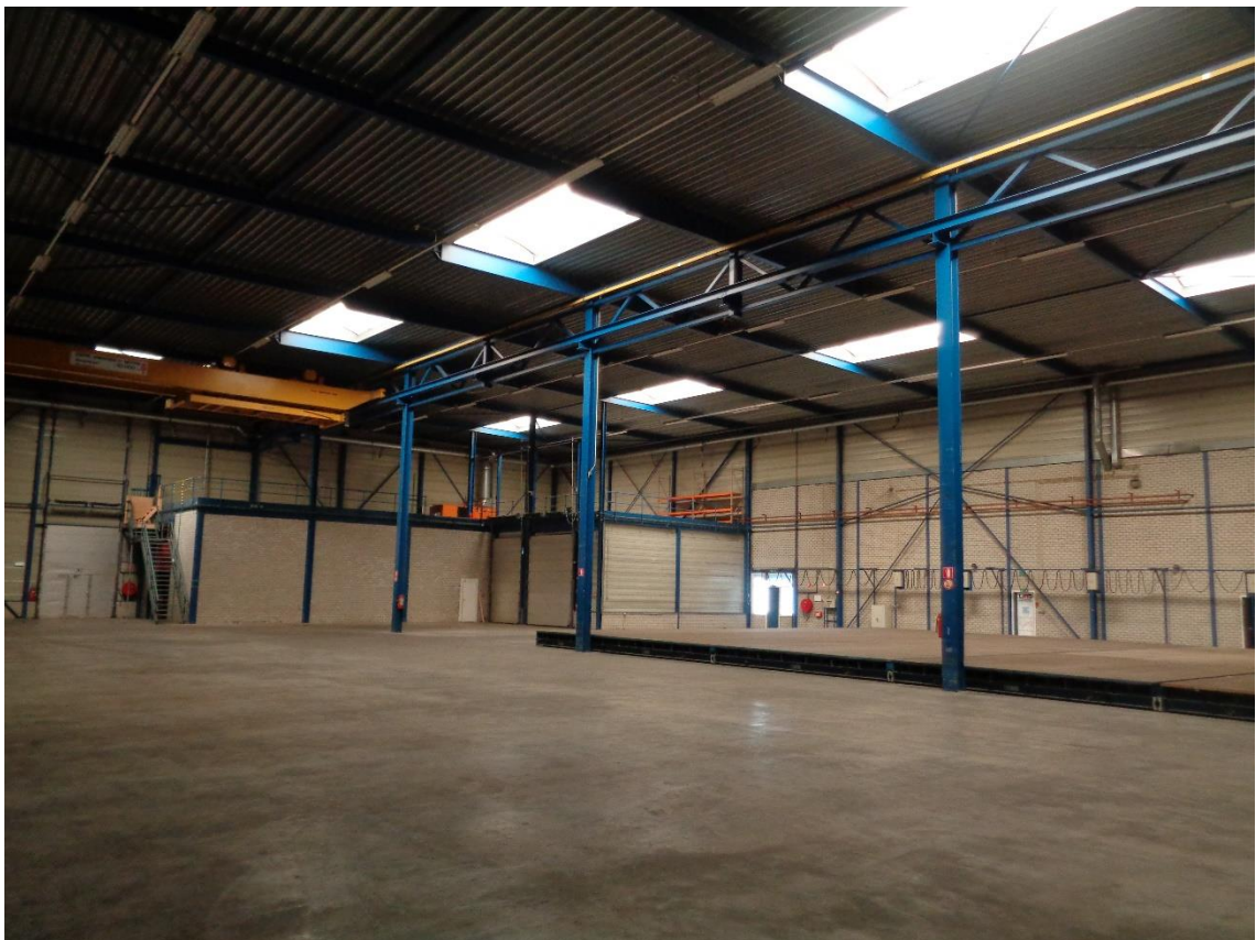
Figuur 5. In de loods zijn geen gaten in het dak, de dakramen of de muren gevonden
