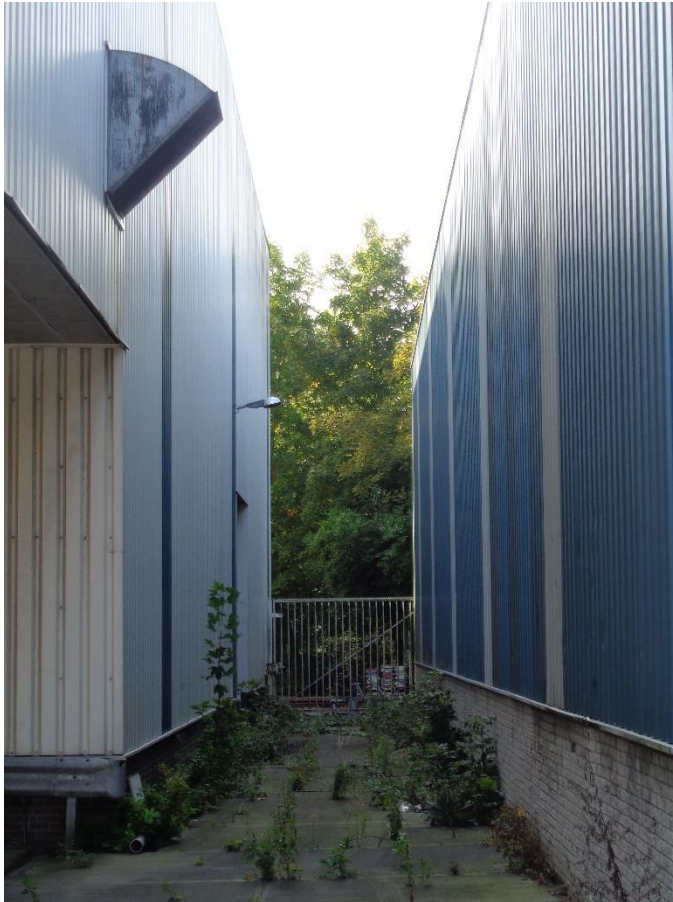
Figuur 8. Zijkant van de loods (links), rechts de loods van Braillelaan 8
