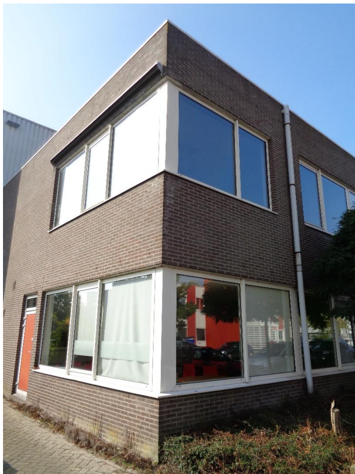
Figuur 2. Het kantoor van bakstenen en met een spouwmuur.
