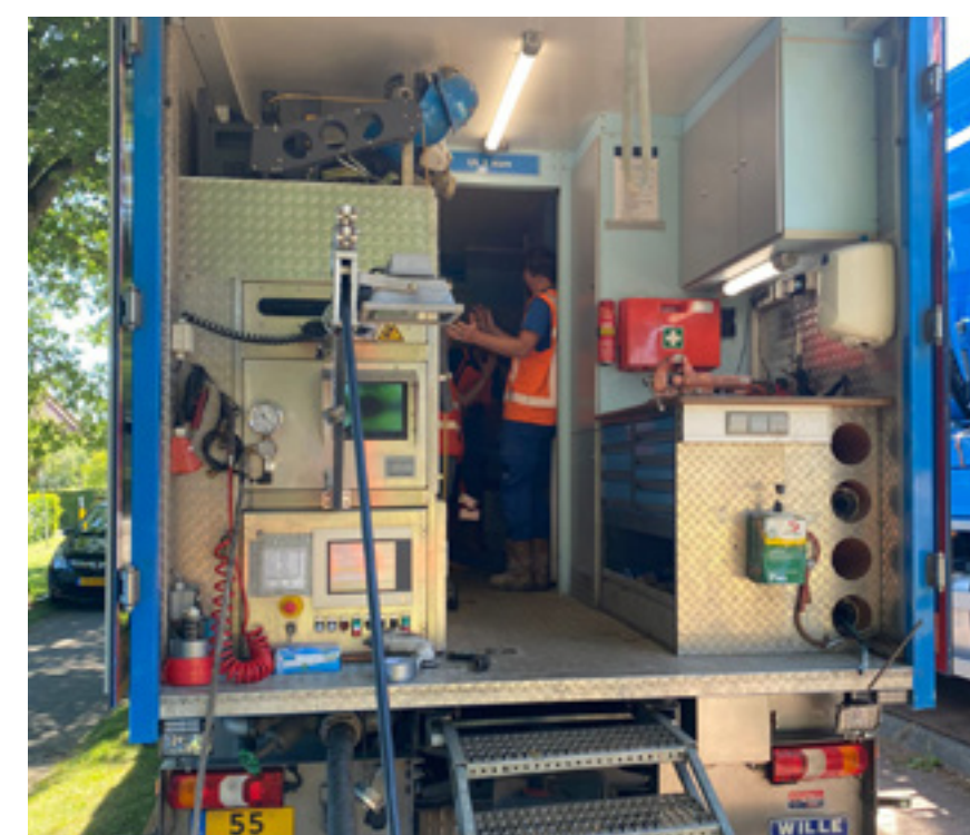
Binnenkant wagen rioolwerzaamheden
