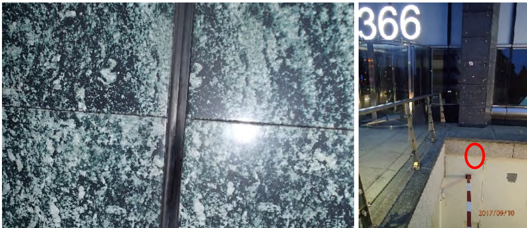
Links een voorbeeld van de muuropzet: gladde natuursteen met rubberen profielen, en rechts een van de open stootvoegen in de toegang tot de parkeerkelder.
