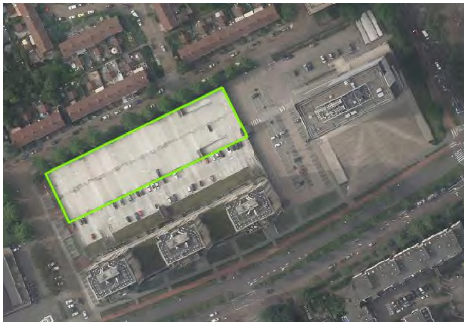
Figuur 2 Luchtfoto met de locatie van de garage waarop de zonnepanelen worden gesitueerd.
