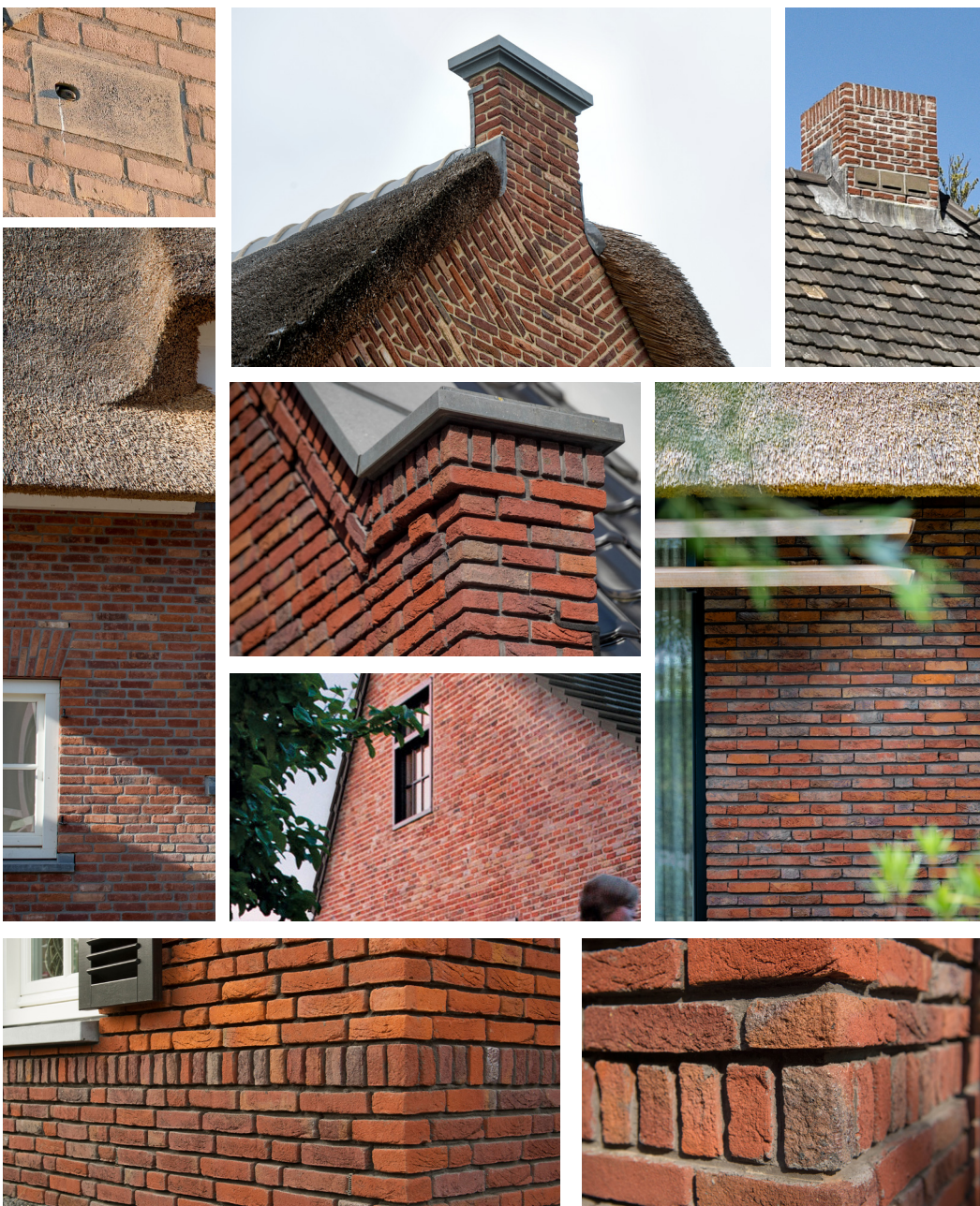
Metselwerkgevels met verzorgde detaillering in verbanden en hoekoplossingen
