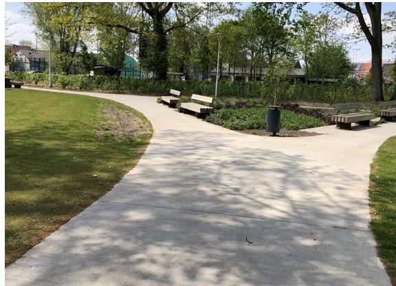
Hoofdwandelstructuur, ter plaatse gestort beton
