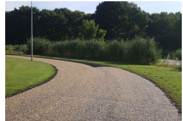
Asfalt rijbaan met parkkarakter in deelgebied west
