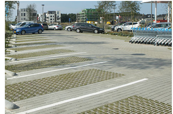
Rijbaan in gesloten betonstraatsteen in zelfde grijsint als parkeervakken
