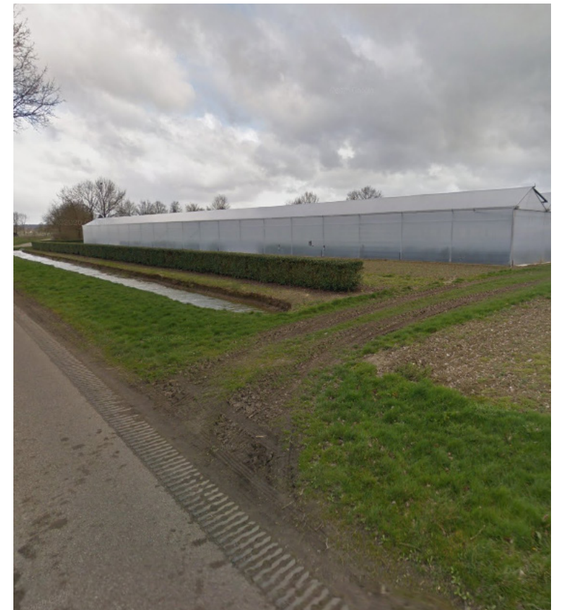
Afbeelding 6: de onverharde inrit aan de zuidzijde
