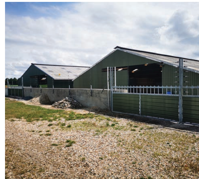
Beeld huidige zakelijke entree naar de loodsen en sheds vanaf de Drieburgseven. Afscheiding met keermuur.
