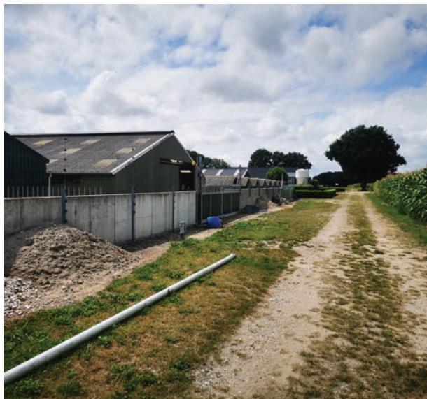
Beeld huidige situatie zandweg Drieburgseven met keermuur en loodsen.
