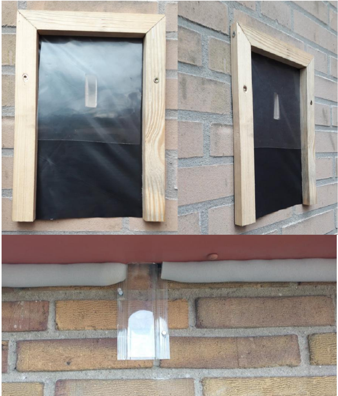
Figuur 6.2 Boven: detailfoto vleermuisflap bij open stootvoeg. Onder: detailfoto vleermuisoker bij open stootvoeg (voorbeeld). Bron: Ecogroen.
