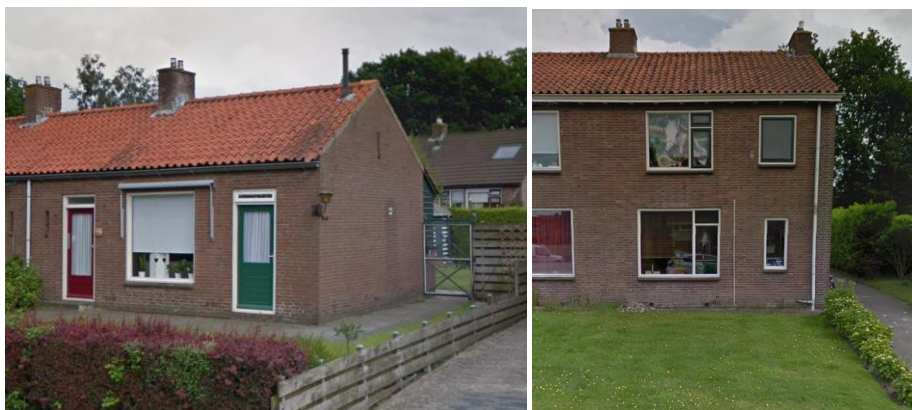
Figuur 1.2 Impressie van de te slopen woningen. Links: seniorenwoningen aan de Gelderingen. Rechts: duplexwoningen aan de Blaankamp.
