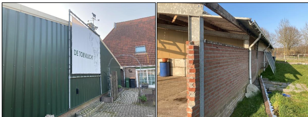
Figuur 2.3 (links): Impressie van de voorgevel van de stalconstructie, ingevuld met metalen damwand en een kunststof daklijst, met op de achtergrond de woning; Figuur 2.4 (rechts): Impressie van de zijgevel van de stalconstructie, de constructie is al deels gedemonteerd.
