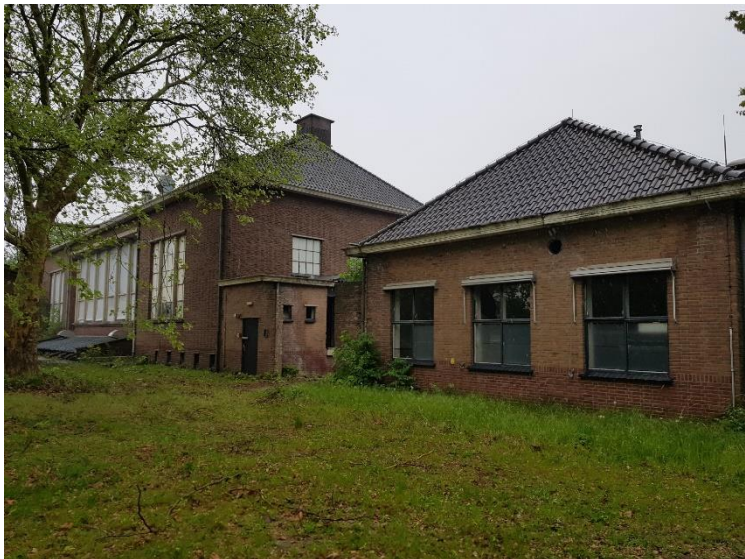
Figuur 52. Achterzijde Keukengebouw.
