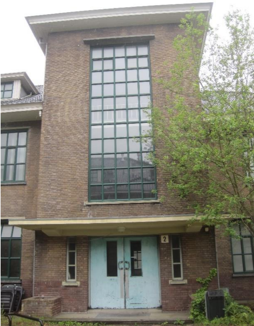
Figuur 45. Voorportaal gebouw 2.
