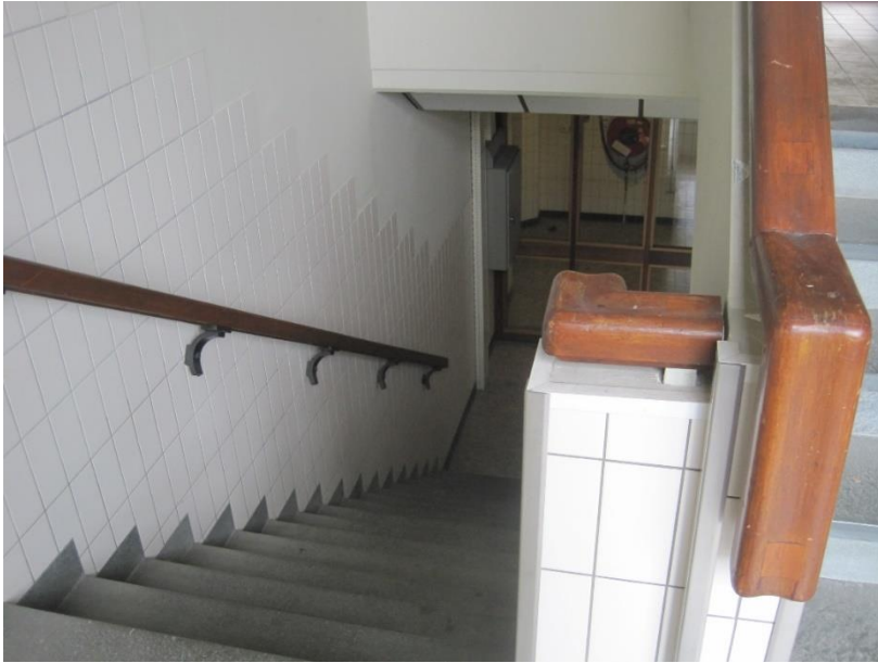
Figuur 48. Gedeelte leuning en tegels trappenhuis gebouw 2.
