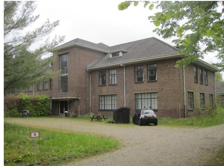
Figuur 41. Voorzijde gebouw 3.
