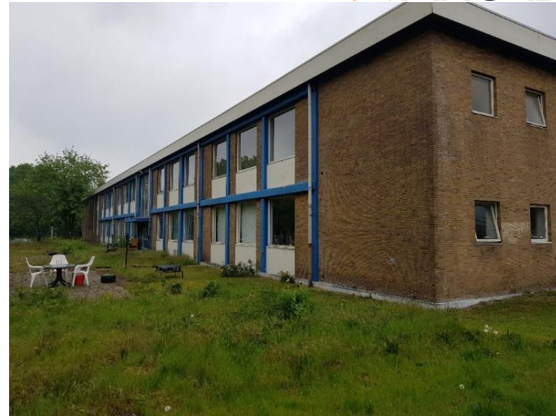
Figuur 98. Impressie gebouwen voormalig AZC-terrein. Gebouw AZC-B.
