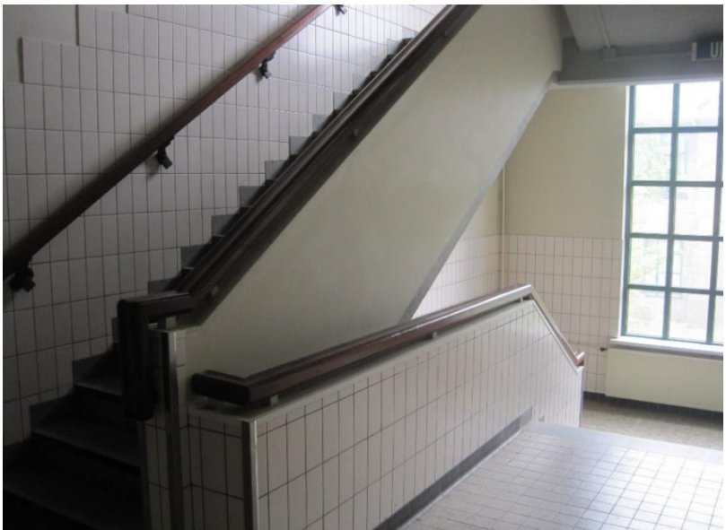
Figuur 46. Trappenhuis gebouw 2.
