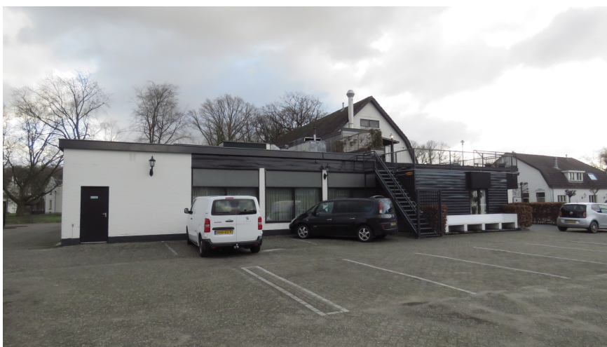
Afbeelding 4: Zicht op de bebouwing vanuit het westen.
