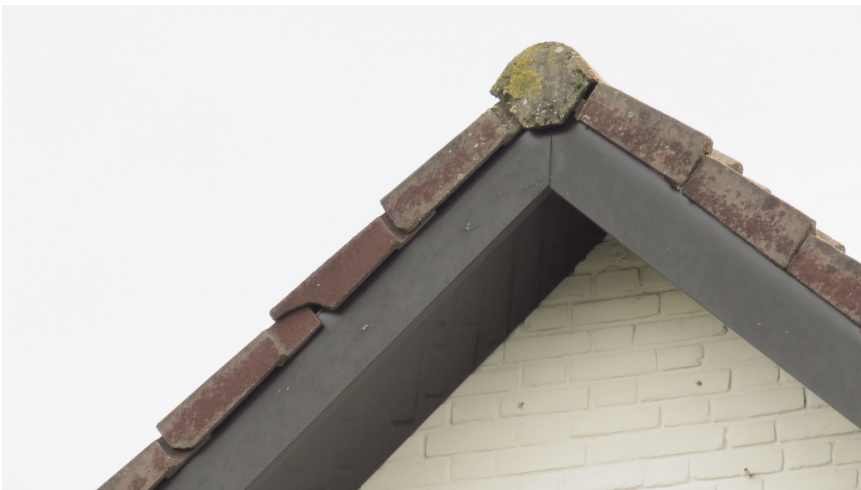
Afbeelding 12: Kieren onder overhangende dakpannen kunnen vleermuizen toegang verschaffen tot het dakvlak.
