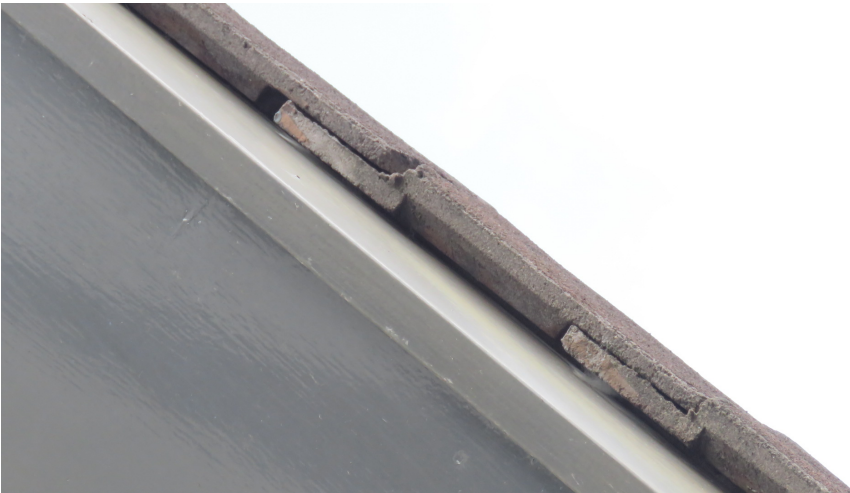
Afbeelding 9: Aan de kopse gevels sluiten de dakpannen zeer nauw op de dakrand.
