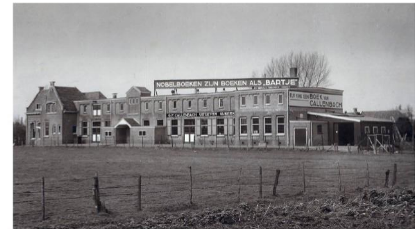
Foto 2 - Historische foto oorspronkelijke uitgeverij Callenbach
