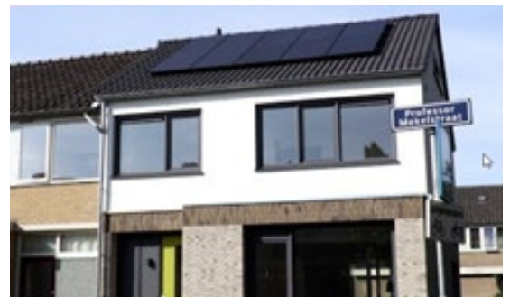
Brabant Wonen, renovatie Schadewijk
