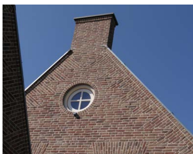
Schoorsteen als tuit van tuitgevel
