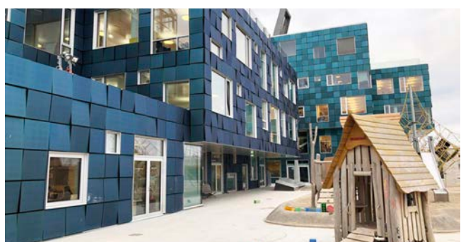
Copenhagen International School, Copenhagen In de gevels zijn nieuwe vormen van PV systemen toegepast.
