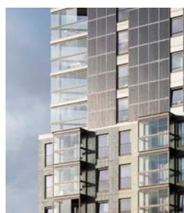
Spakler, Amsterdam (EPC = 0,0) PV op het dak en in de gevels
