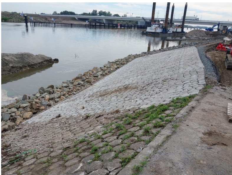
Figuur 14 Aanleg van de dijkbekleding op de Vossemeerdijk
