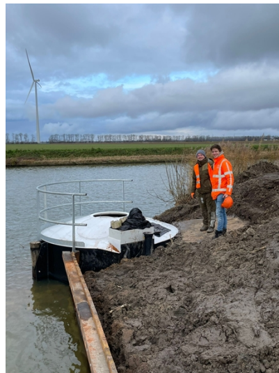
Figuur 20: aanleg vispassage Oldebroekertocht
