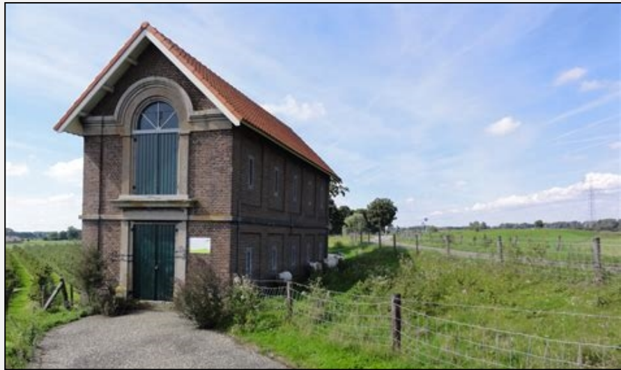
Dijkmagazijn Waalbandijk Afferden
