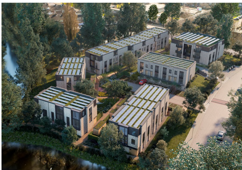
Afbeelding 28 | Voorbeeld van zonnepanelen op plat dak
