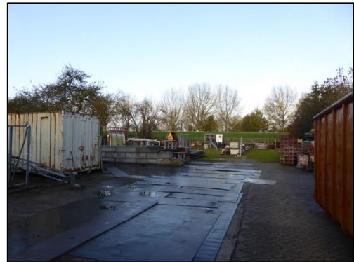
De opslagruimte van het aannemersbdrijf.
