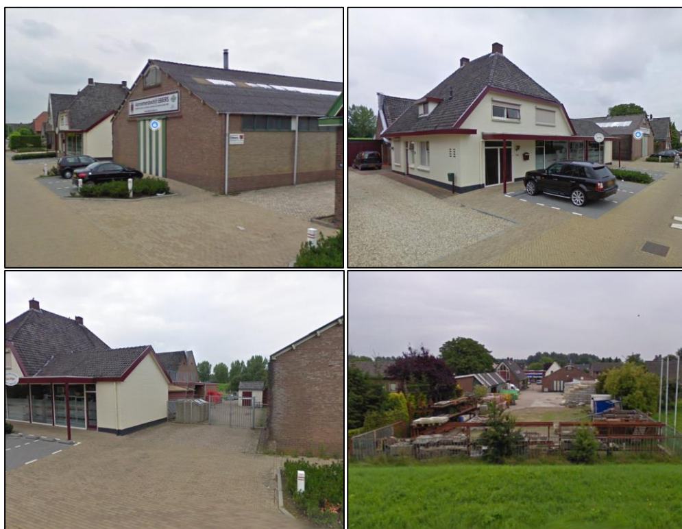
Impressie huidige situatie plangebied (Bron: Google Streetview).
