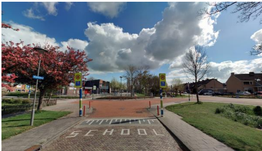
Figuur 13 Schoolzone met tekst 'school', totempalen en waarschuwborden met adviessnelheid 15km/uur
