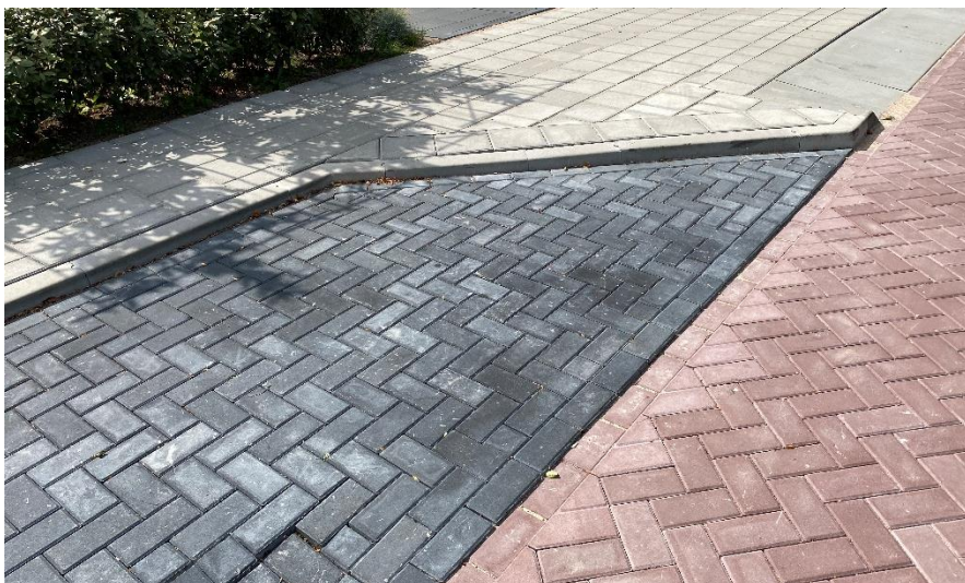
Figuur 10 langsparkerend betonstraatsteen antraciet, elleboogverband, uiteinden in een hoek van 45 ° aangelegd.
