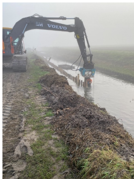
Figuur 27 Aan de slag met gecreosoteerde oeverbeschoeiingen
