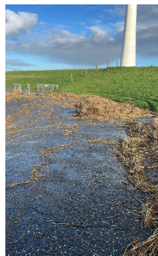
Figuur 12 Vloedmerk na storm op Westermeerdijk, november 2024
