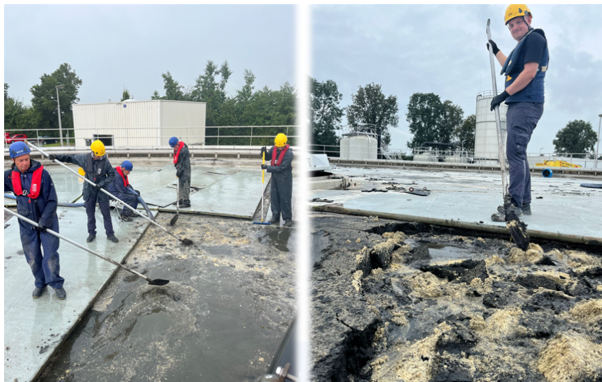
Figuur 29 Vetophoping voorbezinktank AWZI Tollebeek
