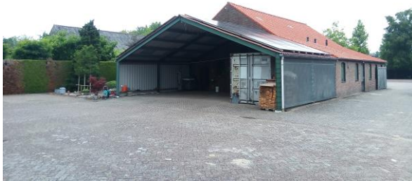
Foto 1: Achterzijde locatie met zicht op noordzijde garage met achterliggende overkapping.
