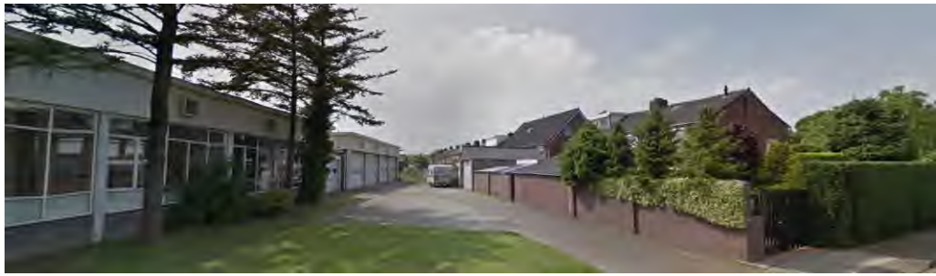
De objecten van de Helderingsstraat gezien op de achtergevel. (Bron:Google)
