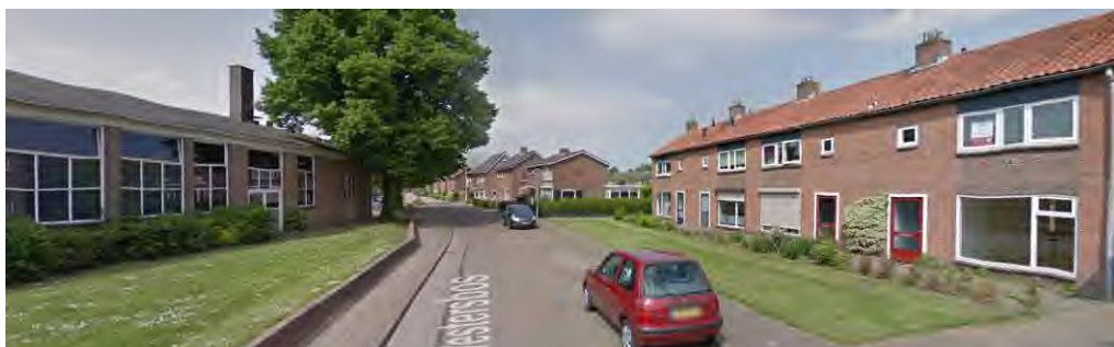
Het woningblok aan het Vestersbos heeft direct uitzicht op de beoogde ontwikkeling. Aan de linkerkant de huidige invulling van het schoolgebouw. (Bron:Google)
