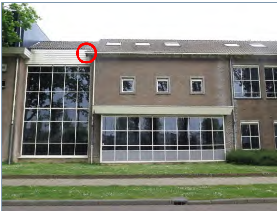
Foto 1. Zuidgevel schoolgebouw met locatie zomer- en paarverblijfplaats (rode cirkel).
