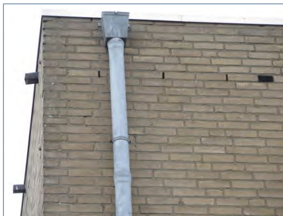
Foto 4. Open stootvoegen: potentiële geschikte in- en uitvliegplek voor vleermuizen.
