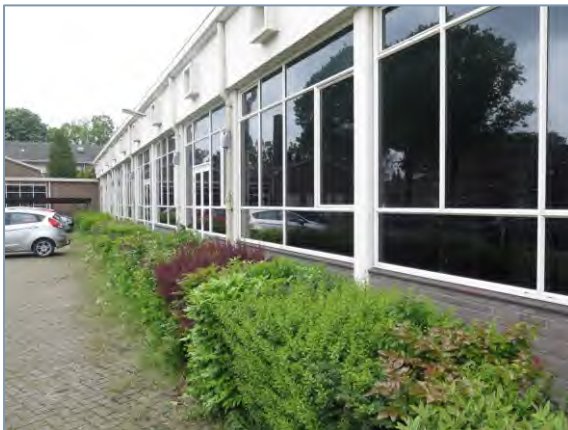
Foto 3. Oostgevel laagbouw (zijde Vestersbos): paar- en zomerverblijfplaats.
