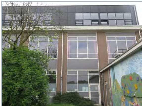
Foto 4. Noordgevel schoolgebouw: paarverblijfplaats.
