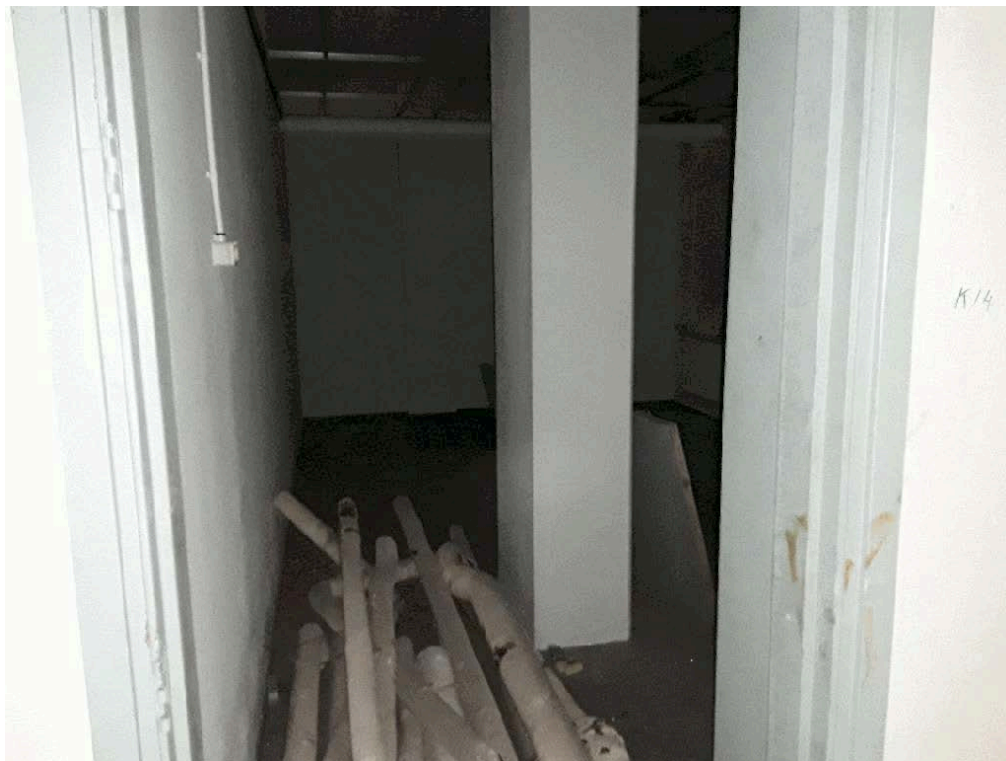
Souterrain technische ruimte (server?) t.h.v. bordes NO, situatie
