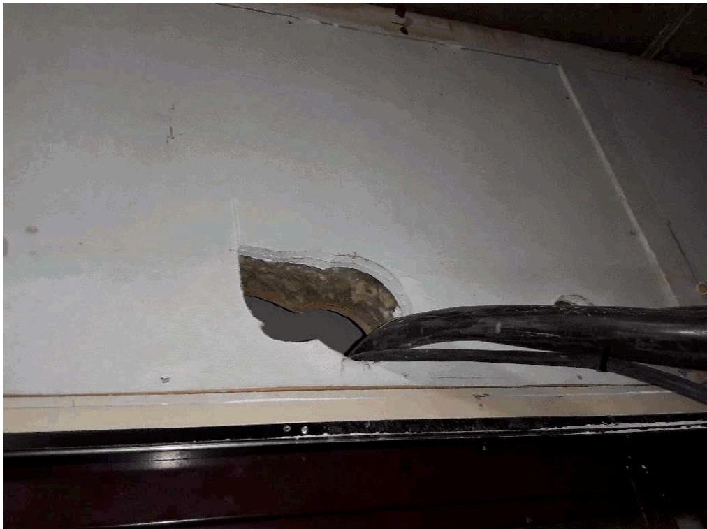
Souterrain gang t.p.v. trappenhuis NO, geen plaatmateriaal DAP bron 43 aanwezig (plaatmateriaal in/boven kozijn DAP bron 20 niet asbestverdacht)
