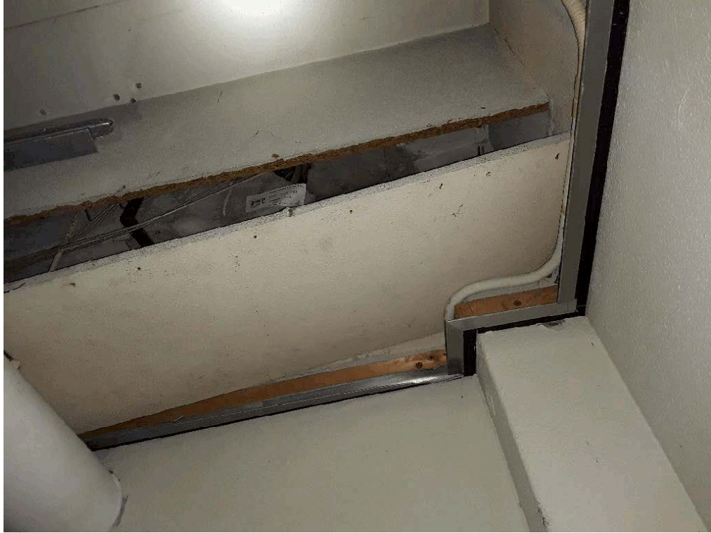
Souterrain kantoorgedeelte archief, kanaal t.b.v. kabels i.p.v. ventilatie DAP bron 28
