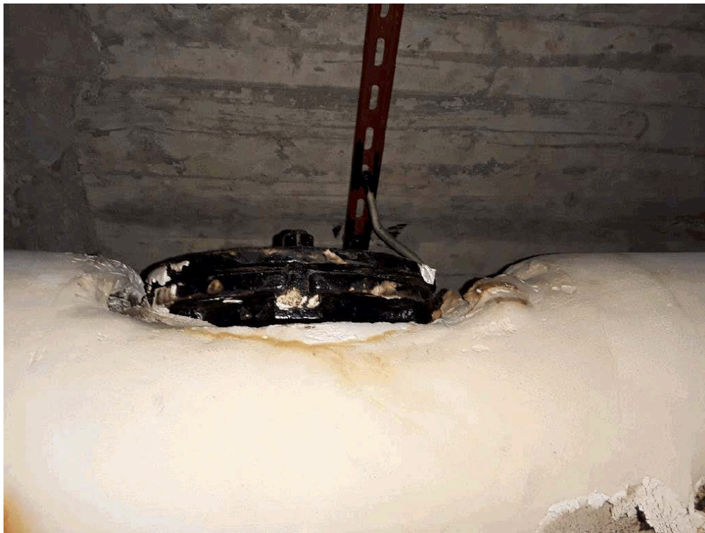
3e verdieping, afdichting gietijzeren hemelwaterafvoer ontstopningsstuk niet asbestverdacht rubber
