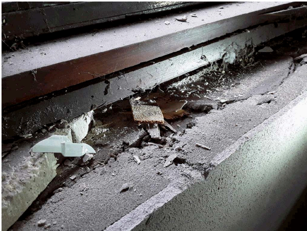
Souterrain gevel binnentuin, stelmateriaal onder vensterbanken hout en karton
