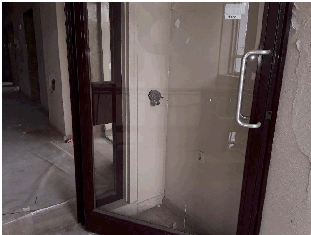
Diverse verdiepingen, afdichting brandleidingen (niet asbestverdacht en reeds bemonsterd door DAP)
