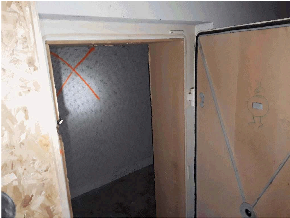
Souterrain ruimte aan einde van de gang ZW, situatie
