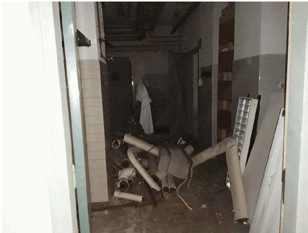
Souterrain technische ruimten t.h.v. bordes NO, situatie
