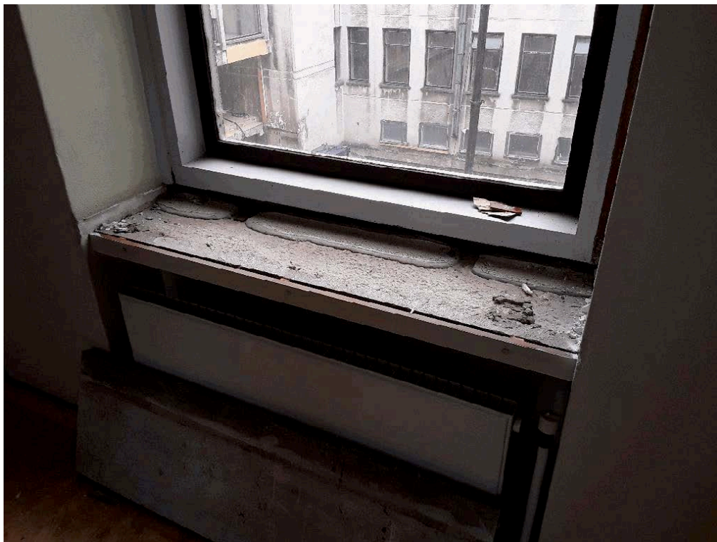
1e verdieping gevel binnentuin, stelmateriaal onder vensterbanken hout
