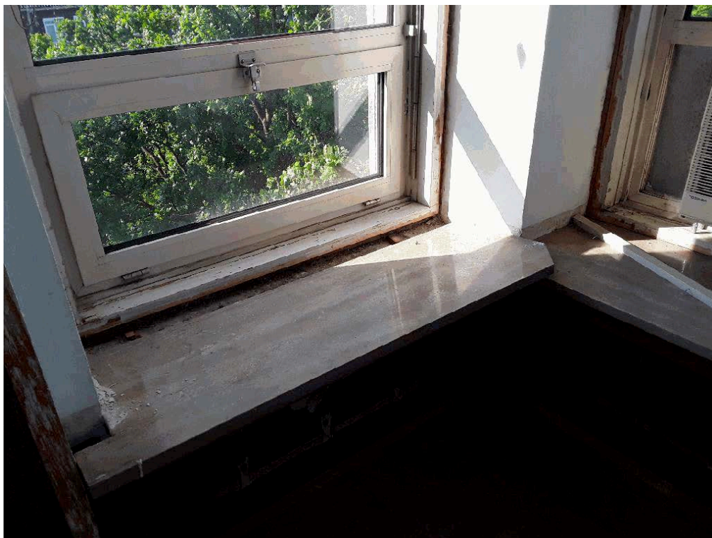
3e verdieping gevel buitenzijde, stelmateriaal onder vensterbanken hout
