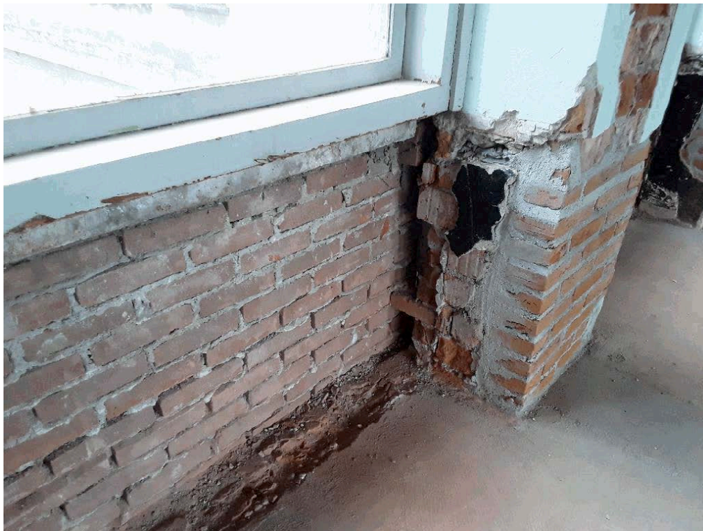
Souterrain archieftruimte, afgesloten deur aan gangzijde
