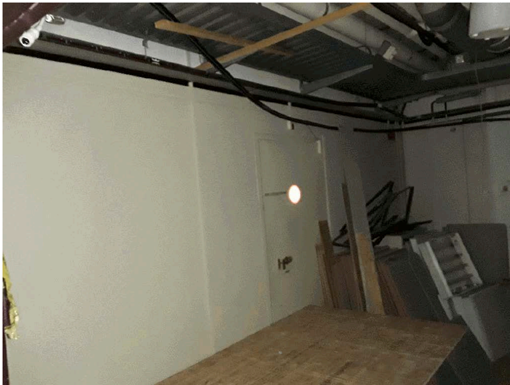
Souterrain gang NO, archiefruimte (kluisdeur Boot bron 37 niet asbesthoudend/kluis DAP bron 10 asbesthoudend) niet toegankelijk (sleutel ontbreekt)
