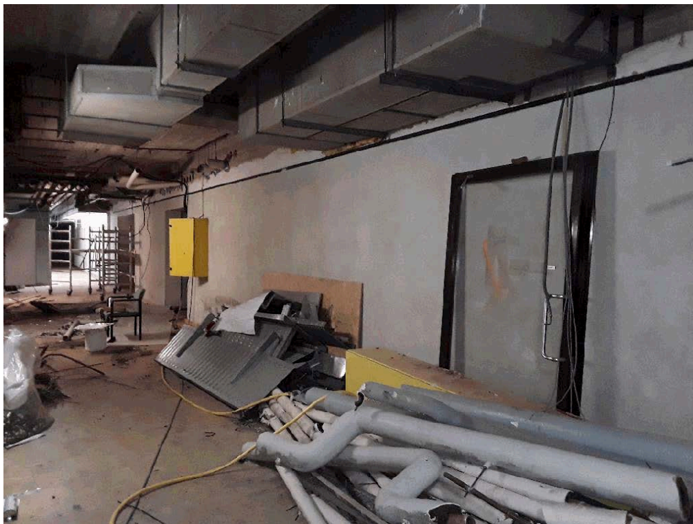
Souterrain hal t.p.v. trappenhuis NW/NO, situatie
