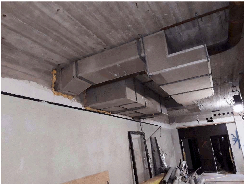
Souterrain gang t.p.v. trappenhuis NO, meerdere ventilatiekanalen DAP bron 5
