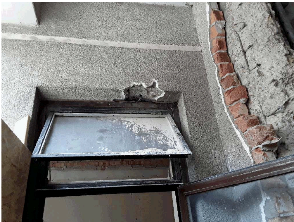
Begane grond gevel binnentuin, geen asbestverdachte materialen in spouw boven gevelkozijnen aangetroffen
