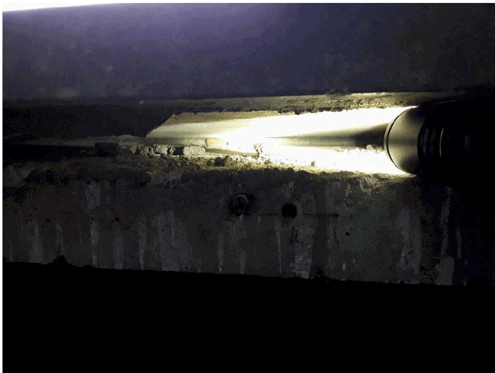
1e verdieping gevel buitenzijde, stelmateriaal onder vensterbanken hout
