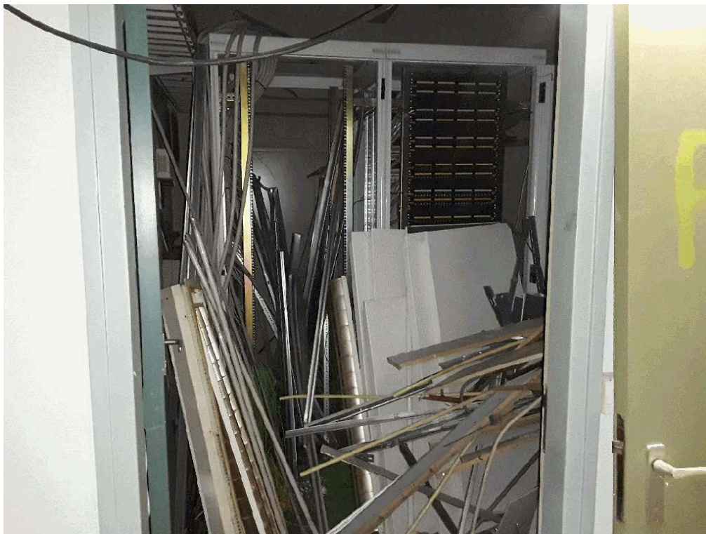
Souterrain technische ruimte t.h.v. trappenhuis NO, situatie
