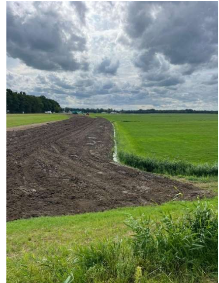
Figuur 17 Grond die vrijkomt bij aanleg duurzame oevers wordt gebruikt op onderbeloop van waterkeringen.
