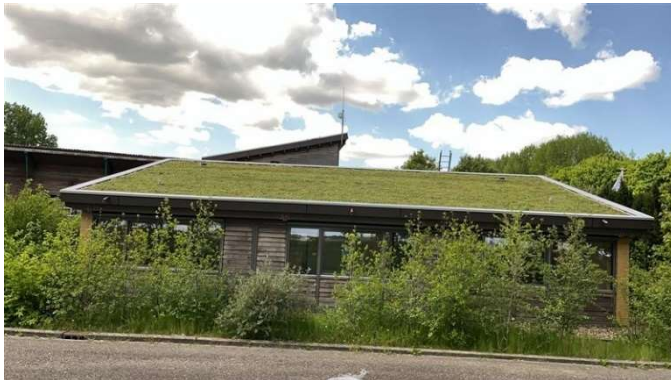
Figuur 36 Energieneutraal kantoor Larserbos
