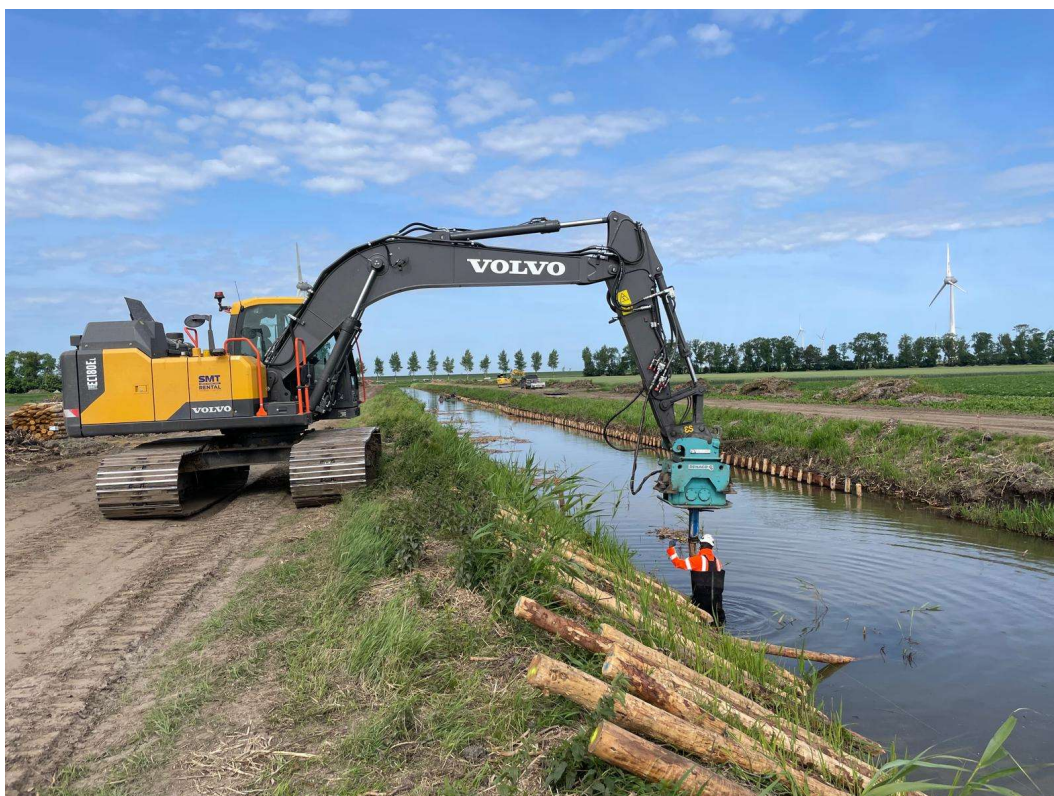
Figuur 16 Het vervangen van een oeverbeschoeiing.
