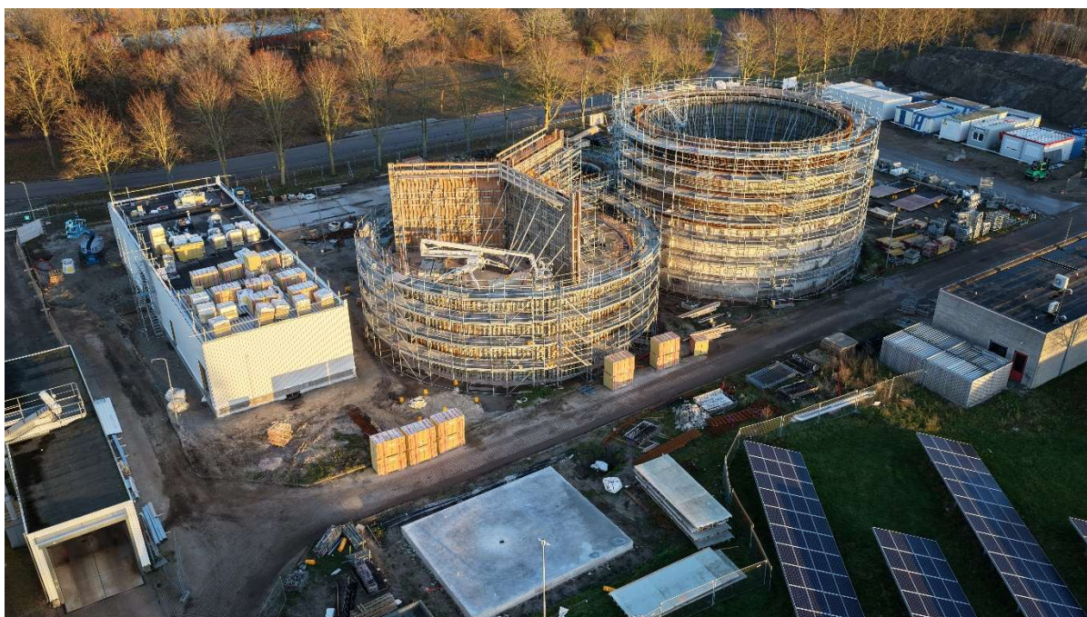
Figuur 32 Ephyra gisting op AWZI Almere in aanbouw
