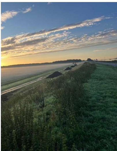
Figuur 9 Aanbrengen grond Eemmeerdijk
