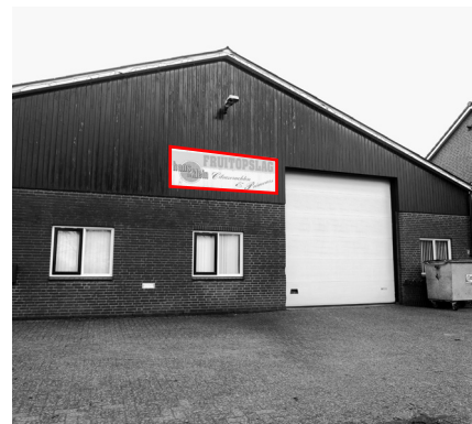
Bescheiden bord tegen de gevel.
