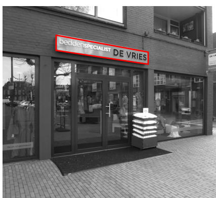
Plaatsing is afgestemd op de gevelindeling.
