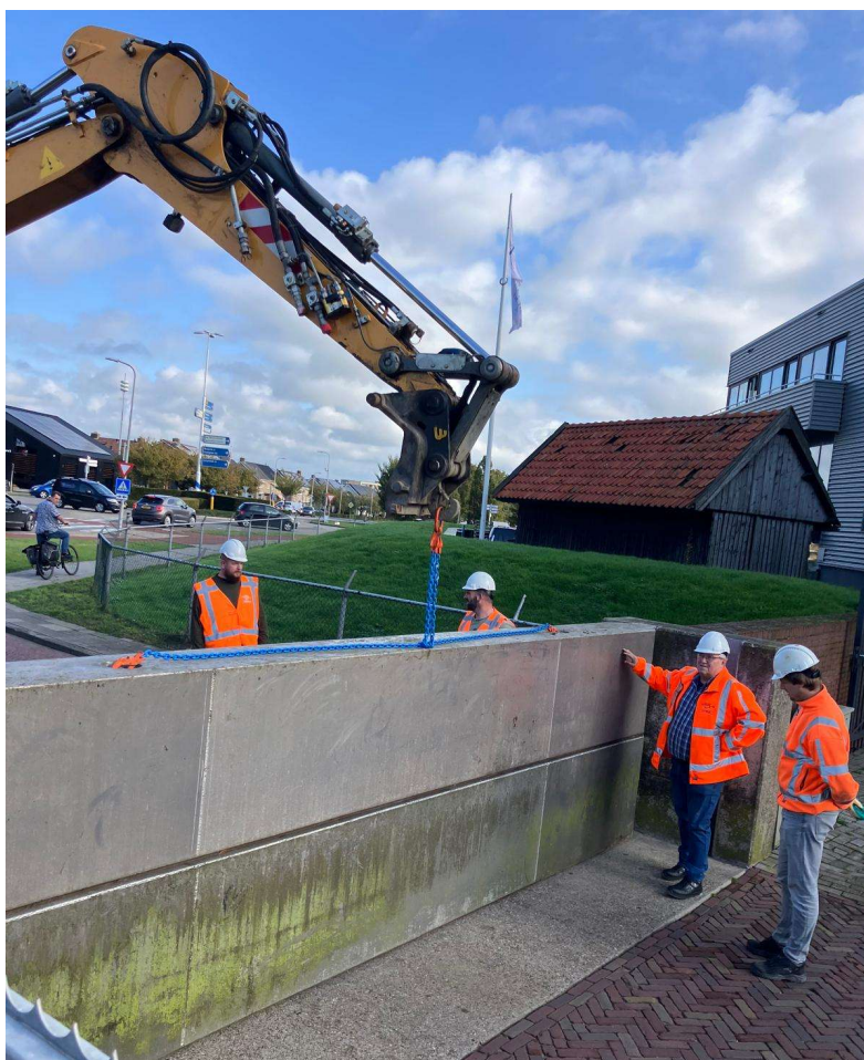
Figuur 2-4 Proefsluiting Coupures Lelystad
