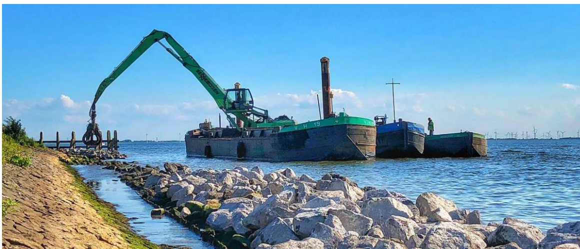
Figuur 2-3 Gepland onderhoud teenbestorting in uitvoering
