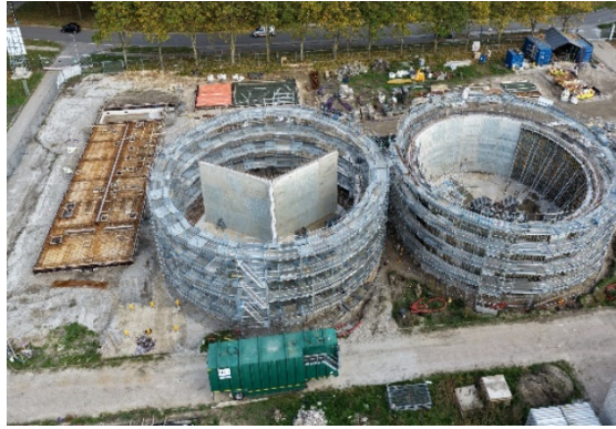
Figuur 1 - Bouw gistingstanks
