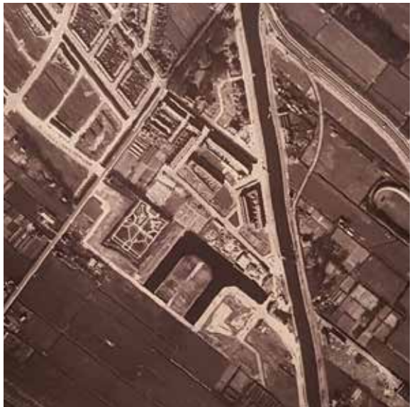
AANLEG PLASPOELPOLDER JAREN '50
