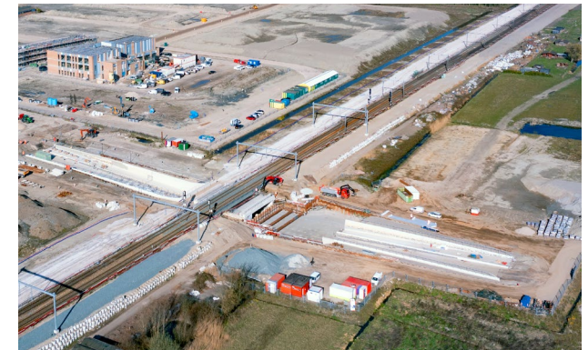
Bouw van de tunnel onder het spoor
