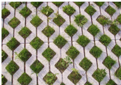
Voorbeeld van de waterdoorlatende verharding in de vorm van grasdallen
