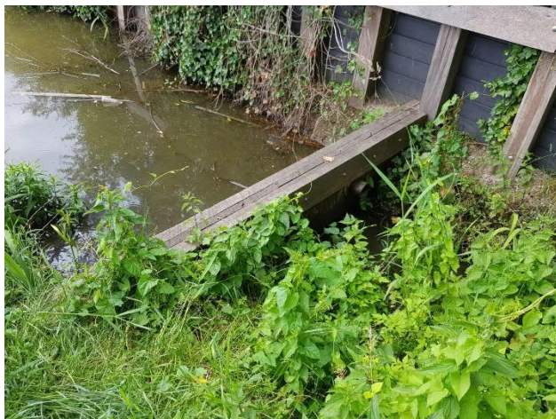
Figuur 2-6 - stuw met knipconstructie RVS-buis 125 mm
