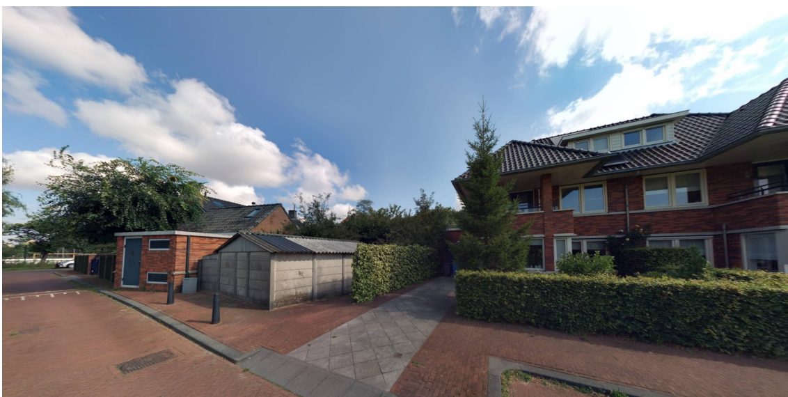
Afbeelding huidige situatie opstal met de woningen aan de Park de Wervelaan
