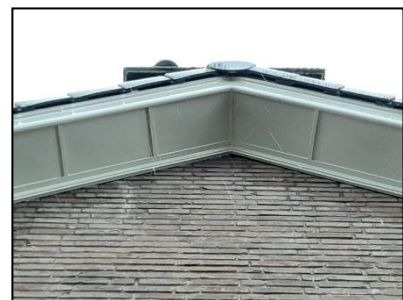
Figuur 17. Ruimtes onder de kant- en nokpannen bij kopgevel van de hoofdbebouwing op Van Vredenburgweg 95.
