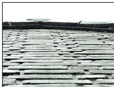
Figuur 16. Ruimtes onder de kant- en nokpannen bij kopgevel van de hoofdbebouwing op Van Vredenburgweg 93.
