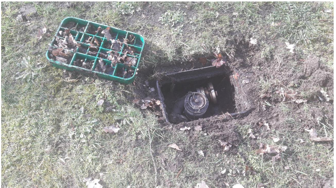
Foto binnenzijde put
