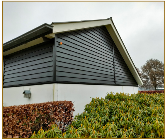
Afb. 2.2: De kopse kant van de schuur gezien vanaf het zuidwesten. Men is voornemens dit deel te verwijderen. Er is een nest van een algemene broedvogel aangetroffen in de rechter dakrand.
