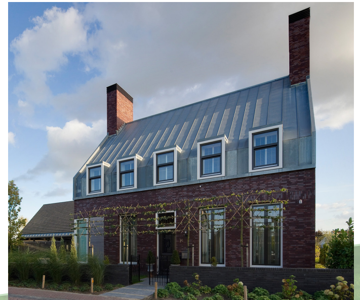
afwijkend in materiaal en detaillering
