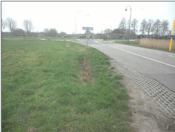
Foto 19: Overige terrein, zijde Burg. Aschofflaan
