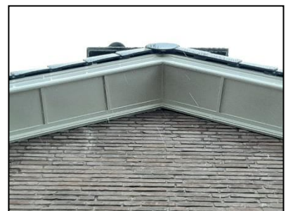
Figuur 16. Ruimtes onder de kant- en nokpannen bij kopgevel van de hoofdbebouwing op Van Vredenburgweg 95.
