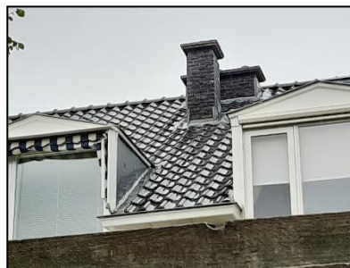
Figuur 13. Hoofdbebouwing op Van Vredenburgweg 95 en 97 met ruimtes onder dakpannen.
