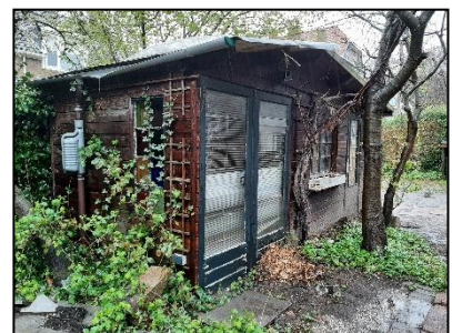
Figuur 8. De te slopen schuur in de noordoostelijke hoek.
