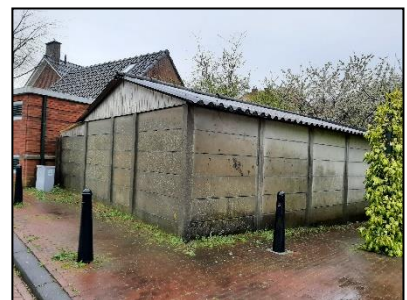
Figuur 11. Westelijke en zuidelijke gevels van de te slopen schuur in de zuidwestelijke hoek van de onderzoekslocatie.
