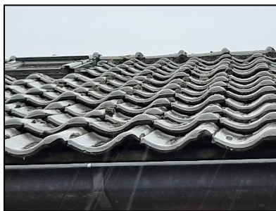
Figuur 12. Hoofdbebouwing op Van Vredenburgweg 91 en 93 met ruimtes onder dakpannen.
