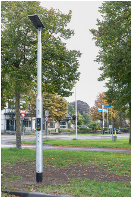
Foto: voorbeeld van een laadlantaarnpaal in de gemeente Renkum. Smart city dus.
