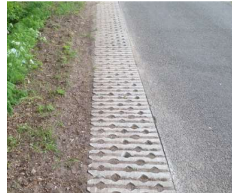
Grasbetontegels langs asfalt rijbaan
