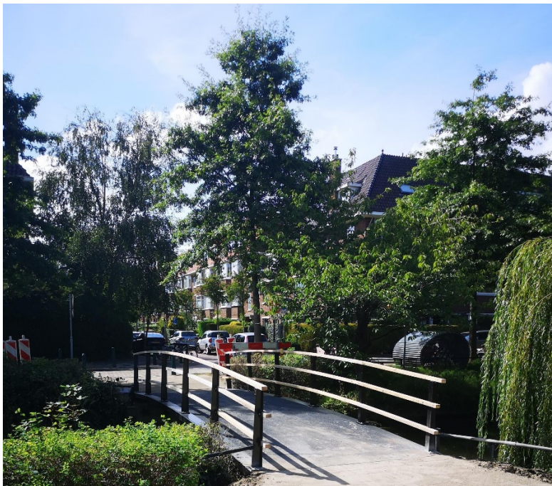
Stalen brug (Thierenskade)
